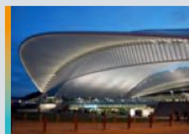
Station / Gare Luik / Liège Guillemins (BE)
