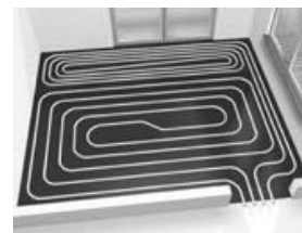
zone périphérique / de vie deux circuits séparés
