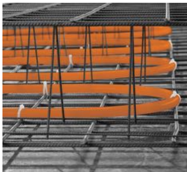
Le tube PexPenta est bien protégé sur l'armature inférieure.
