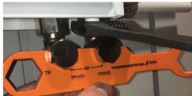
Positionering av SR avstängningar vid åtdragning
