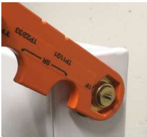
Demontering av ventilinsats
