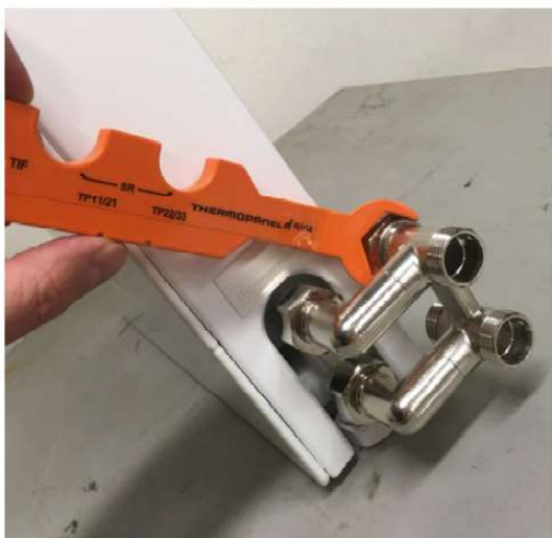
Demontering av ventilinsats
