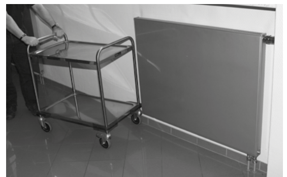
Abb. 76 Sach- und Personenschäden zu vermeiden, ist eines der Ziele der neuen VDI 6036. Deshalb ist der sogenannte „vorhersehbare Fehlgebrauch“ ein grundlegender Bestandteil dieser Richtlinie.
