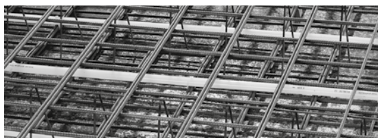
Abb. 84 Industrieflächenheizung
