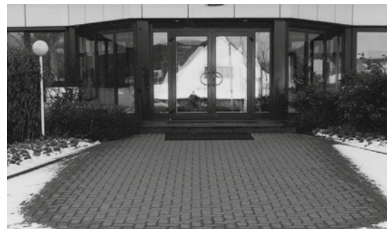
Abb. 88 Freiflächenheizung
