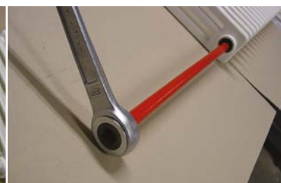
3. Serrage de la barre au raccord de nippage
