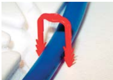
Utilisation de cavaliers sur les Cosydalle à plots P50 Filmée.
