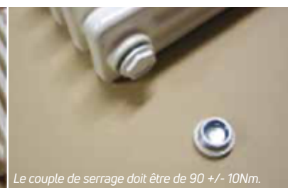
6. Positionnement des bouchons et purgeurs
