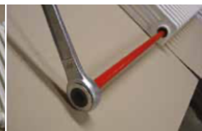
3. Serrage de la barre au raccord de nipplage
