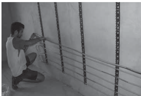
Rysunek 28 railjet układanie rury (instalacja wykonana przez partnera Purmo we Wrocławiu)
