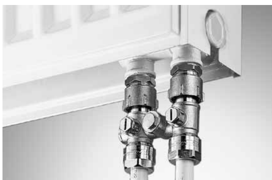
Abb. 24 1-Rohr-Anschluss
