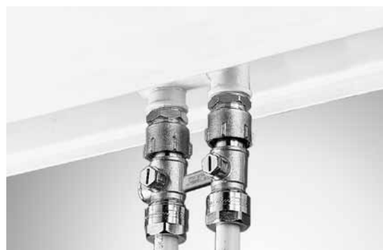
Abb. 61 2-Rohr-Anschluss
