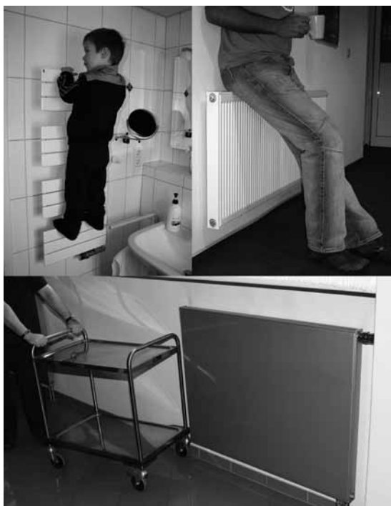
Abb. 127 Sach- und Personenschäden zu vermeiden, ist eines der Ziele der neuen VDI 6036. Deshalb ist der sogenannte „vorhersehbare Fehlgebrauch“ ein grundlegender Bestandteil dieser Richtlinie.
