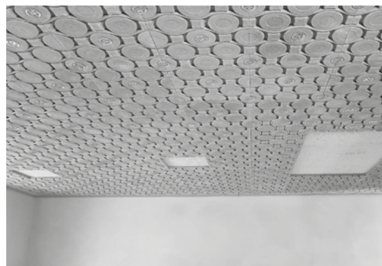
Abb. 68 Lehmsystem eco clay – hier als Deckenheiz- und Kühlsystem
