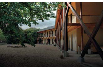
CASTLE LUDWIGSTEIN, NJEMAČKA OBNOVLJIVA ENERGIJA + DEGRADABNI MATERIJALI
