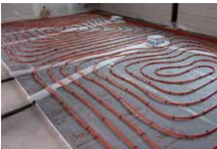
Orangefarbene Rohre: Das neue Verbundrohr Pex-Penta eignet sich optimal für den Baustellenalltag.
