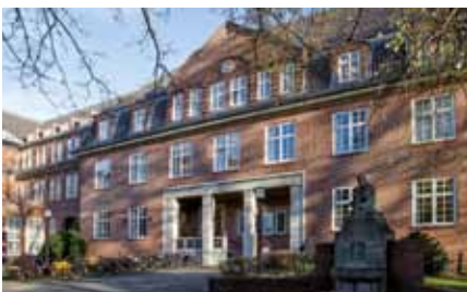
Früher Frauenklinik, heute Kunst- und Mediacampus - beheizt mit Purmo Heizkörpern.
