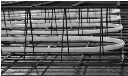
Abb. 64 Das PexPenta-Heizrohr wird mit Kabelbindern auf der unteren Bewehrung fixiert
