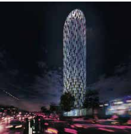
SKYTOWER, BUKUREŠT, RUMUNJSKA RADSON RADIJATORI ZA NAJVIŠU ZGRADU U RUMUNJSKOJ
